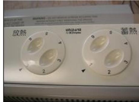
※放熱コントローラーを『1』に設定し、内部ダンパーが閉じているかを、次に放熱コントローラーを『6』に設定し、内部ダンパーが開いているか確認します。
